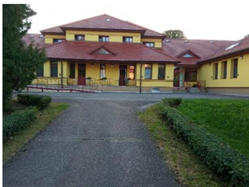
Plocha před opravou
