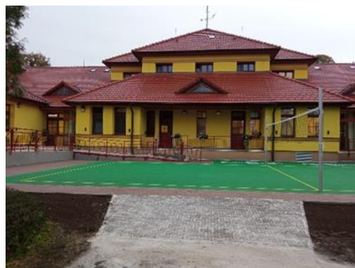
Plocha po opravě
