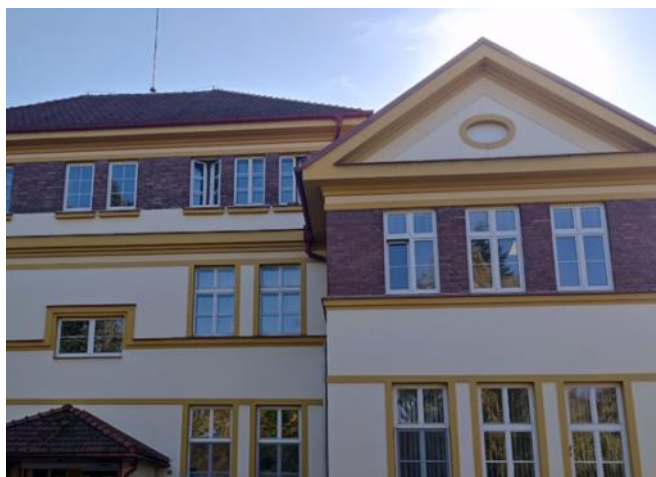
Zahájeny práce na kompletní výměně oken budovy HTS
