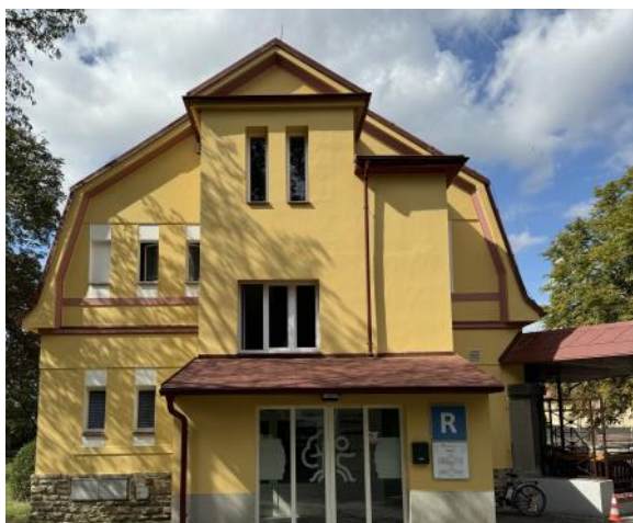
Oprava fasády, soklů a nátěrů budovy R a prodejny Kubík
